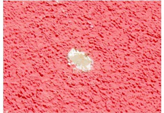
**4. Lochbohrungen für die Dübel:** Bohren Sie je nach Dübelsorte die gekennzeichneten Löcher ins Mauerwerk. Bringen Sie die Dübel ins Bohrloch ein.
